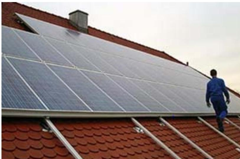
Se construyen con perfiles de acero galvanizado en caliente y cumple las normas UNE 37-501 y UNE 37-508, con un espesor mínimo de revestimiento de 80 micras de espesor de zinc para asegura una protección completa contra las inclemencias climatológicas y, por tanto, una mayor duración y mantenimiento. Cumple con la normativa básica de la edificación (NBE-AE-88) y dimensionado con la norma NBE-EA-95, por lo que será capaz de soportar los módulos y las sobrecargas de nieve y viento.
