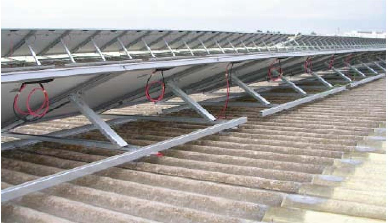
Se construyen con perfiles de acero galvanizado en caliente y cumple las normas UNE 37-501 y UNE 37-508, con un espesor mínimo de revestimiento de 80 micras de espesor de zinc para asegura una protección completa contra las inclemencias climatológicas y, por tanto, una mayor duración y mantenimiento. Cumple con la normativa básica de la edificación (NBE-AE-88) y dimensionado con la norma NBE-EA-95, por lo que será capaz de soportar los módulos y las sobrecargas de nieve y viento.
